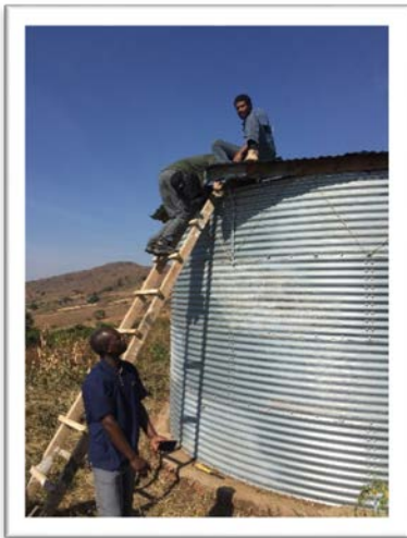
Inspectie van de watertank uit 2015 in Kilangala
