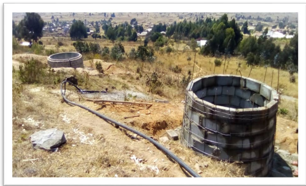
Foto boven: de twee tanks klaar voor de buitenmantel
