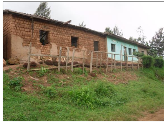
Op de foto het gebouwtje in Kagarama, waarin de medische hulppost is gevestigd. Het wordt voorzien van dakgoten, een regenwateropslag en een waterzuivering.
