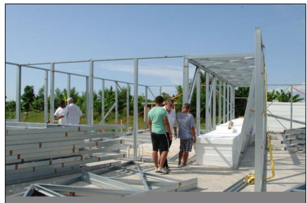
Op de foto een deel van het karkas van de nieuwe school op Haïti vlak voordat de bouw werd stilgelegd.
